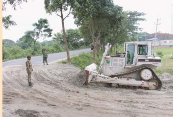
মহাসড়কটির EMBANKMENT নির্মাণের চলমান কাজ
