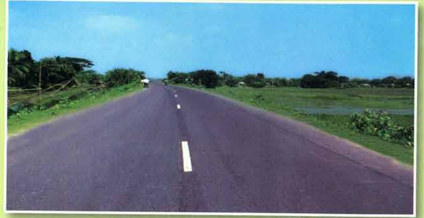
নবনির্মিত গৌরনদী-আগৈলঝাড়া-পয়সারহাট-কোটালীপাড়া-গোপালগঞ্জ সড়ক
