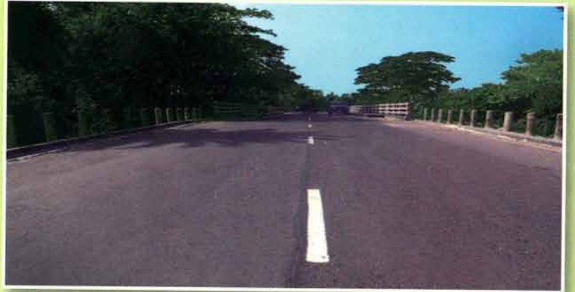
গৌরনদী-আগৈলঝাড়া-পয়সারহাট-কোটালীপাড়া-গোপালগঞ্জ সড়কে নবনির্মিত তাড়াশী সেতু
